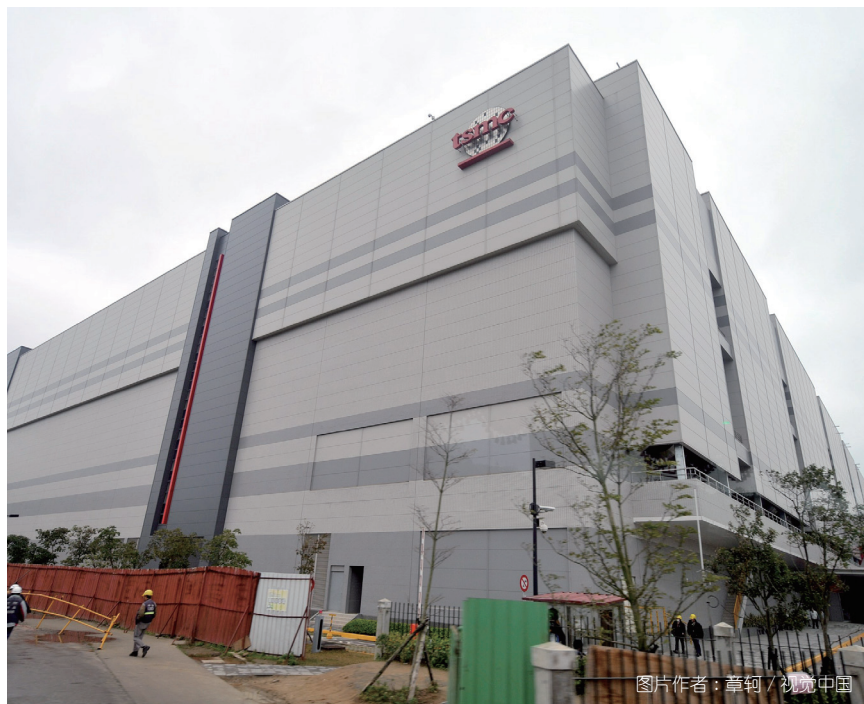
/ 台湾新竹科学园区台积电厂房
